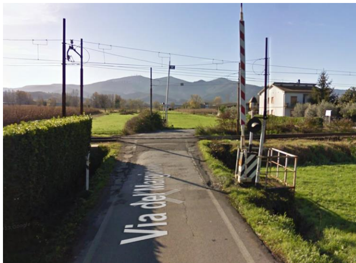
Figura 1-3 Vista del passaggio a livello esistente alla p. km 39+139 di Via del Marginone
