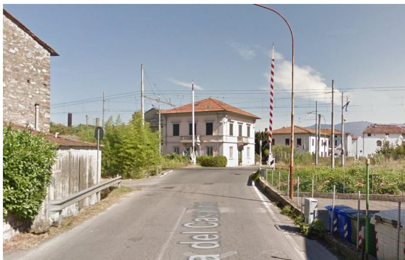
Figura 1-2 Vista del passaggio a livello esistente alla p. km 38+738 di Via del Casalino
