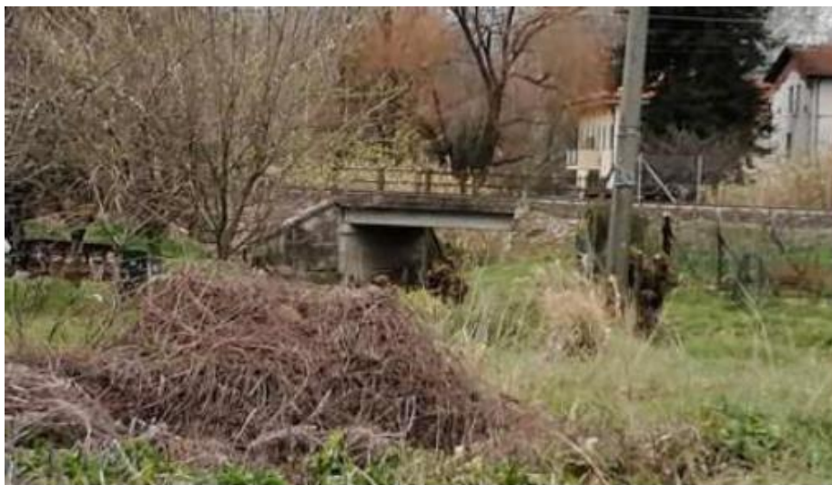
Figura 1-1 Vista del ponte esistente su Canale Ozzoretto al km 41+195
