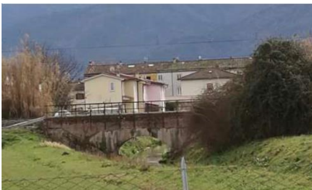
Figura 1-2 Vista del ponte esistente su Canale Ozzoretto al km 40+579,85
