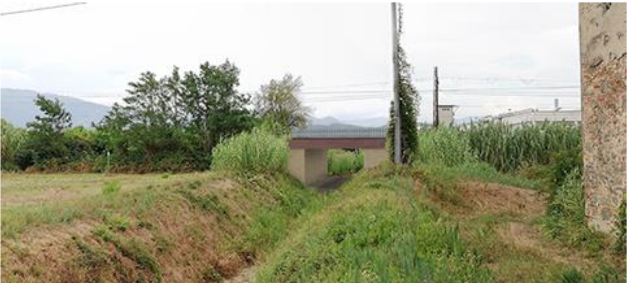
Fig. 4.13 Immagini ante-operam e post operam (fotosimulazione) dell'intervento eseguito in corrispondenza del km 33+360 sul torrente Tazzera.
