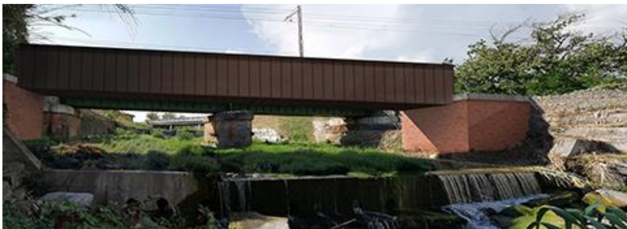
Fig. 4.23 Immagini ante-operam e post operam (fotosimulazione) dell'intervento eseguito in corrispondenza del km 22+011 sul torrente Pescia di Collodi.
