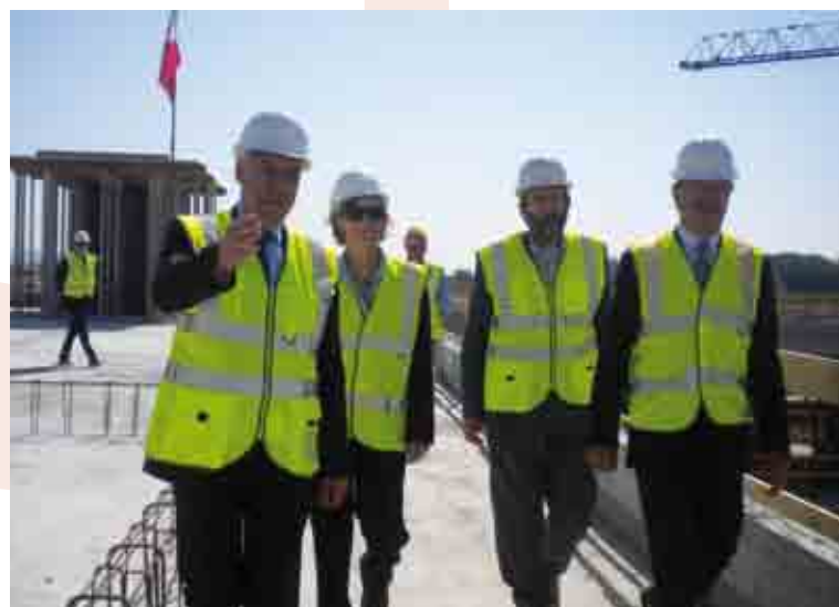
Sopralluogo al nuovo ospedale
